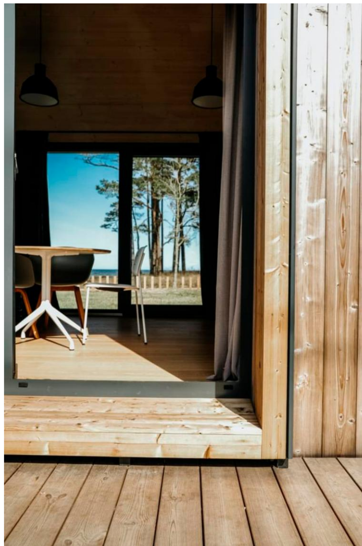
Detail krytiny a dřevěného obkladu
